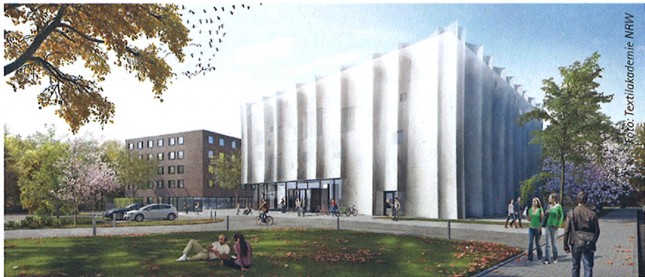
Die Architektur soll die Funktion des Gebäudes symbolisieren: Der dreigeschossige Bau wird von einer textilen Fassade umspannt.
