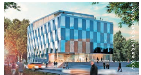
Durch den Wechsel von Glas- und Photovoltaik- elementen an der Gebäudefassade entsteht der Eindruck eines blauen Hauses.
