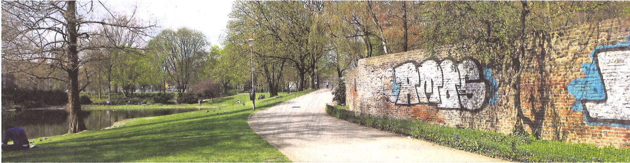
Die Stadtmauer am Geroweier. Hier ist die Mauer noch größtenteils erhalten. Sie wird derzeit saniert.
