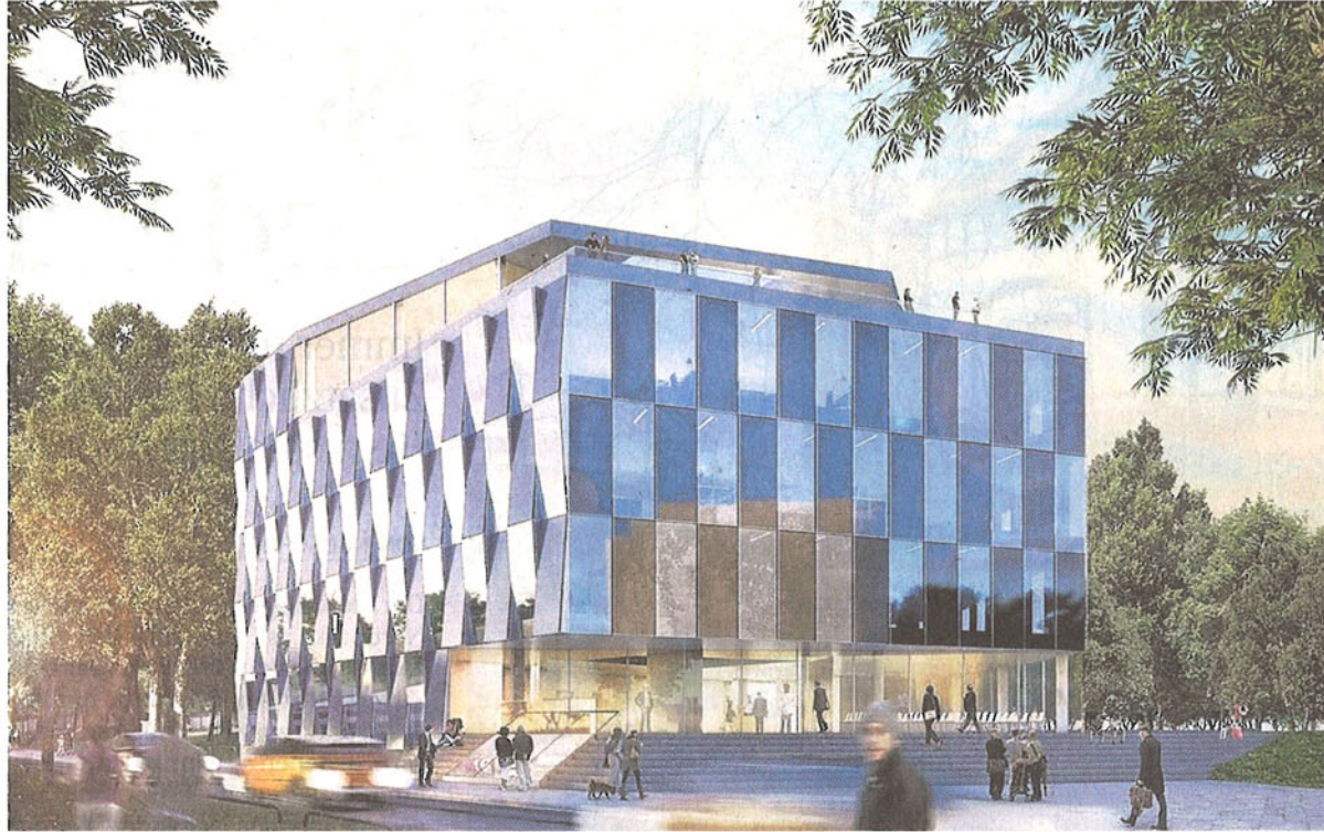
Glas- und Photovoltaikmodule bilden im Wechsel die Fassade des Gebäudes.
